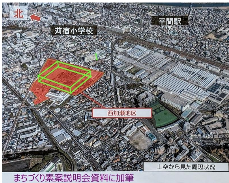
図 1 上空から見た西加瀬倉庫建設予定地の周辺の状況
